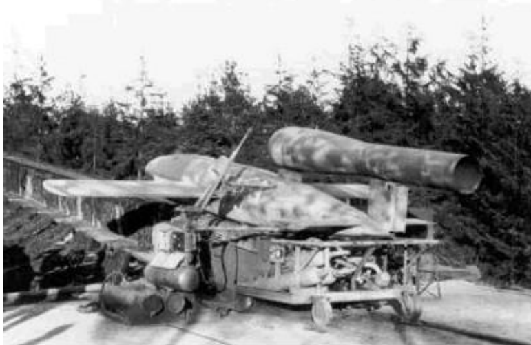
Abb. 5: Flugbombe Fi 103, auch V1 genannt, und der Sprengkopf, auch „Lastraum“ genannt, mit 830 kg Sprengstoff © https://www.kreis-ahrweiler.de/kvar/VT/hjb2005/bilder/V1.gif
