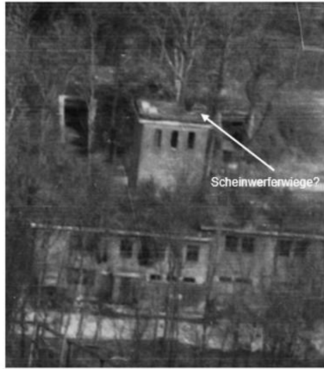
Abb. 38: Detailansicht Schlauchurm Feuerwache
