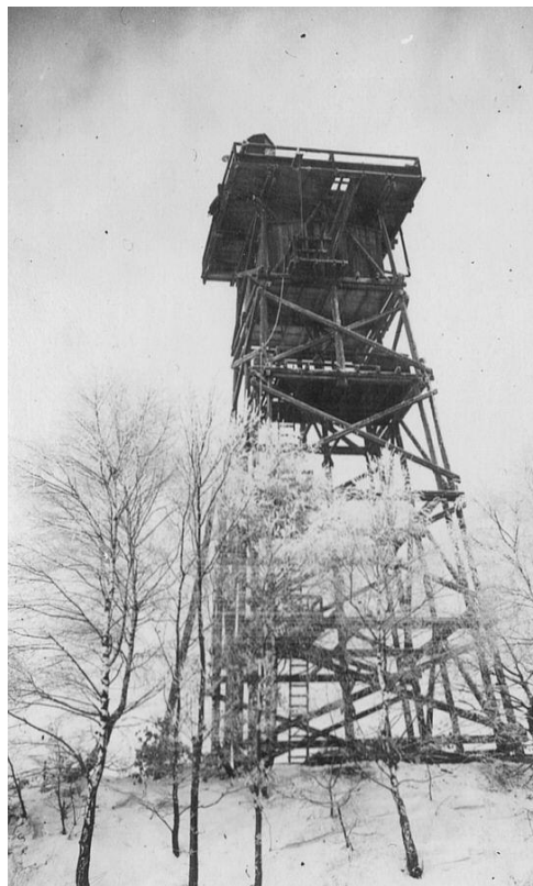
Abb. 15: schwerer Flakturm mit Aufenthaltsbereich und Zwischenstützen © https://www.buero-immekus.de/flakturm_2.htm
