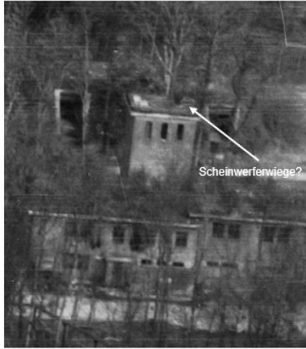
Abb. 38: Detailansicht Schlauchturm Feuerwache
