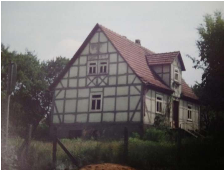
Abb. 41: Ehemaliges Fachwerkhaus Kreppelweg 3 © Foto Breitenstein
