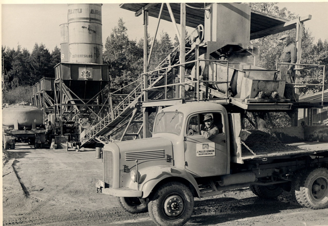
Abb.3: Betonmischanlage mit LKW, Fotograf ungenannt, 1958.
