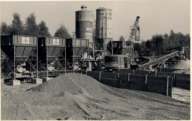
Abb.4: Betonmischanlage, Fotograf ungenannt, 1958.
